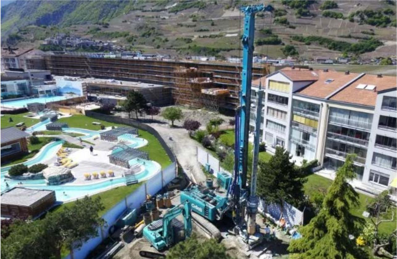
Entnahme- und Rückgabebrunnen zur Versorgung einer Wasser-Wasser-Wärmepumpe für die Heizung des Hotelkomplexes und der Bäder.
