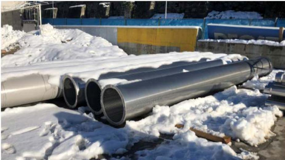
Im Zuge des Umbaus vom Einkaufszentrum Wiesental in Chur wurden zwecks energetischer Nutzung zwei Vertikalfilterbrunnen aus Edelstahl realisiert. Die Bohrung wurde mittels Greifer und Verrohrungsanlage abgeteuft.
