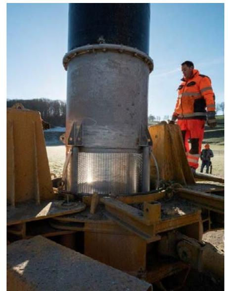
Beispiel eines Stahlfilterbrunnens aus Wickeldrahtfilter. Die Verstärkungen, die speziell für die Installation und Verlegung entwickelt wurden, erlauben das Erreichen der geforderten Tiefe.
