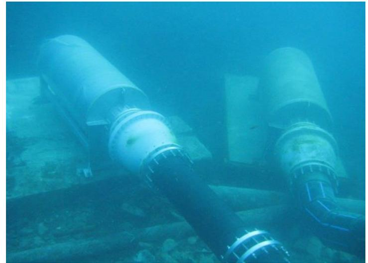
Dieser Ansaugfilter aus Wickeldraht einer Meerwasserentsalzungsanlage wurde auf die Insel Giglio in der Toskana geliefert.
